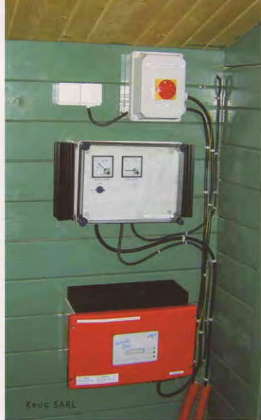
Système d'injection réseau comprenant de haut en bas : boîtier de sectionnement aux normes EDF, contrôleur de tension et onduleur.
